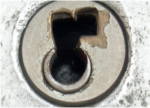
Abb. 15: Öffnung für Markierschlüssel Typ 49.
